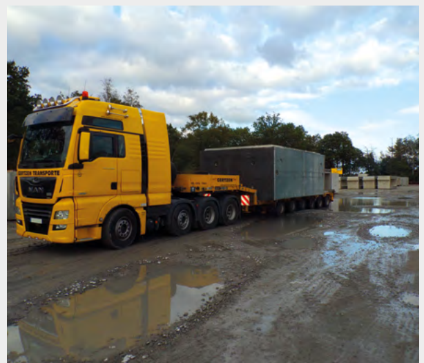
Die Anlieferung der insgesamt 17 Fertigteile erfolgte zum großen Teil liegend. (Bild: Alber Fischer GmbH)
