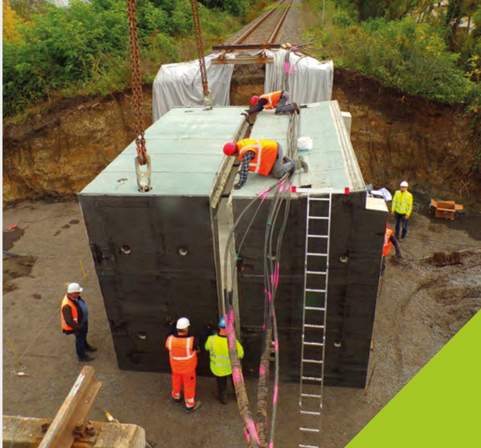
Maßarbeit: Die Stahlbetonfertigteile passen perfekt zusammen. (Bild: Albert Fischer GmbH)
