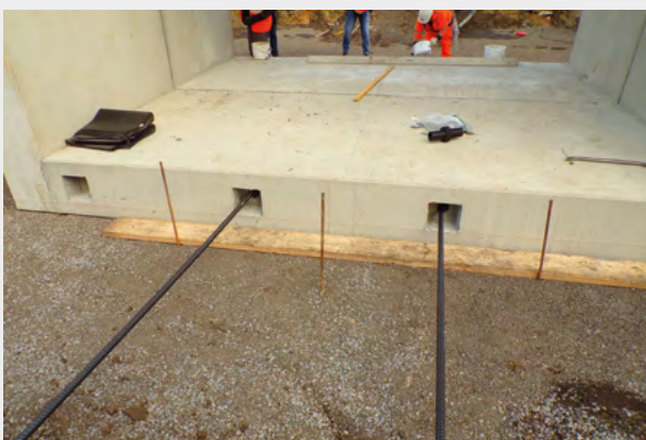
Die Verspannung der Fertigteile erfolgte mit Hilfe eines Stabspannsystems im Verbund. (Albert Fischer GmbH)
