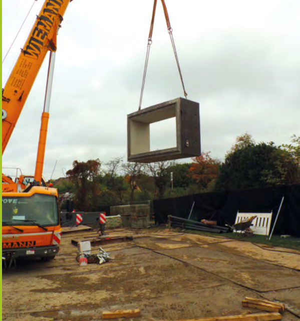
Die Fertigteile mit einem Einzelgewicht von bis zu 50 Tonnen wurden per Autokran einzeln in die Baugrube gesetzt. (Bild: Alber Fischer GmbH)
