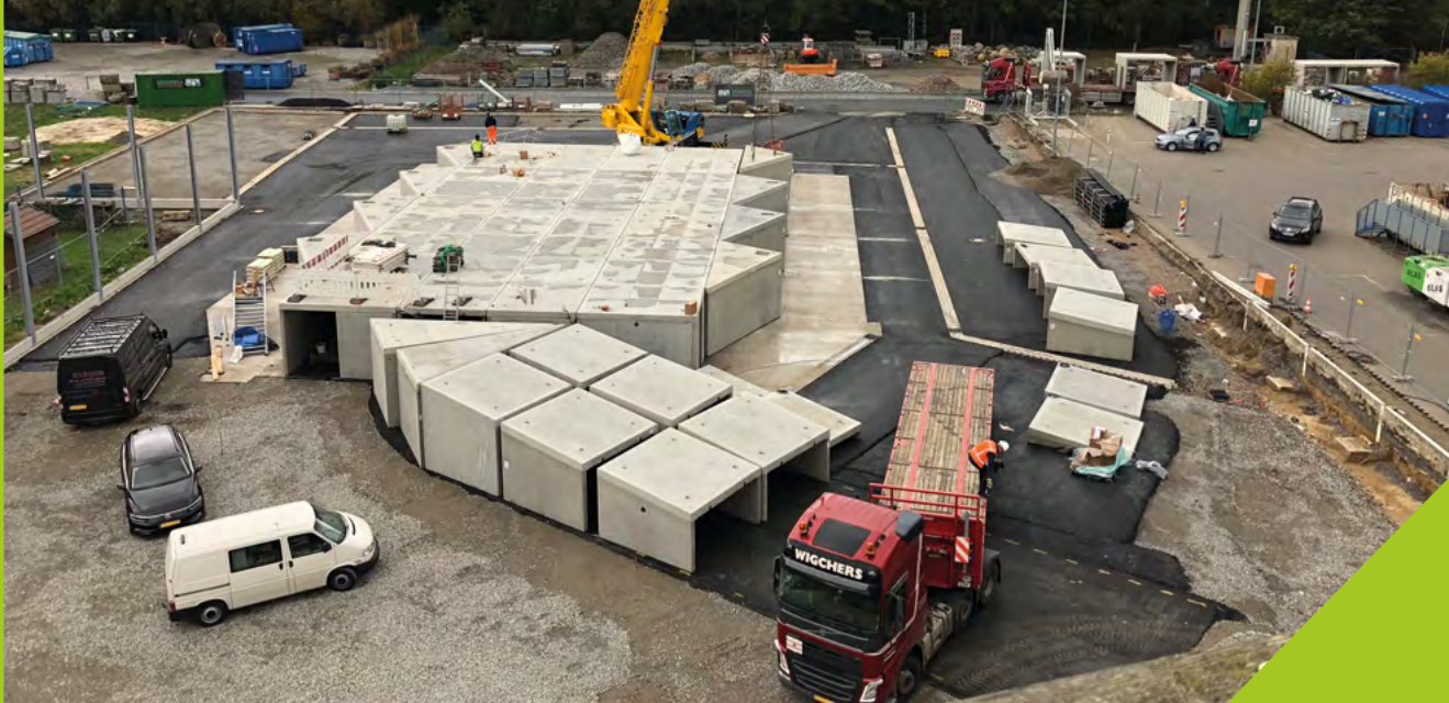
Die Montage der 78 Fertigteile für den Wertstoffhof erfolgte in nur 5 Tagen. (Bild: Modulo Wertstoffhöfe GmbH)
