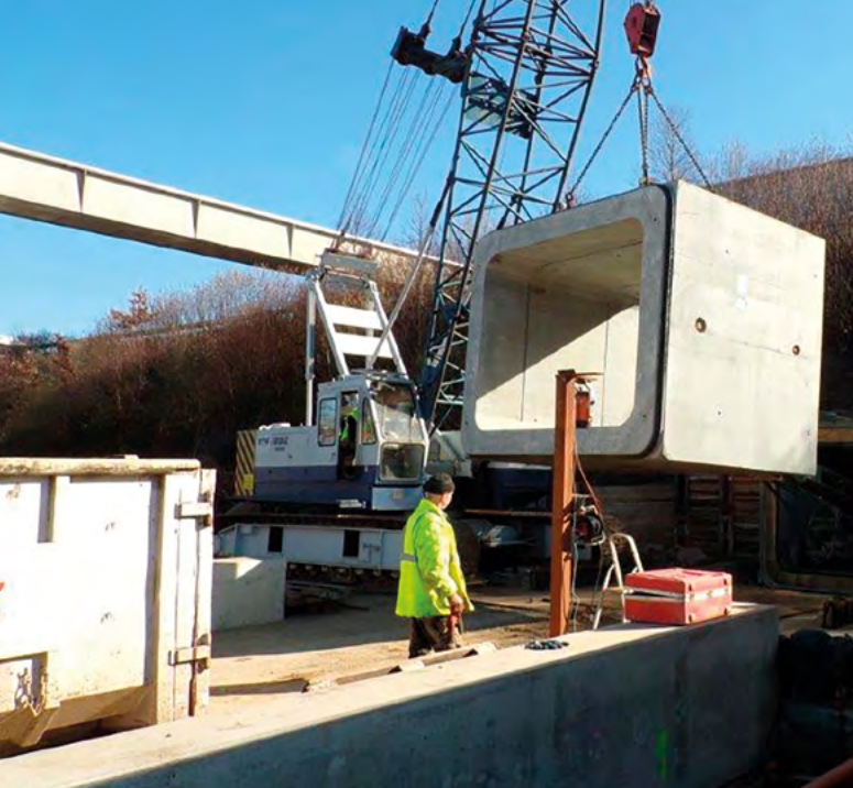
Die ca. 33 Tonnen schweren Rahmenprofile werden nach und nach unter der Autobahn durchgepresst. (Bild: VTW Vortriebstechnik Weiss GmbH)
