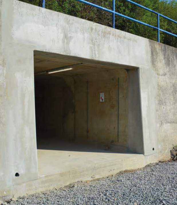
Blick auf die Südseite des Tunnels. (Bild: Kleihues Betonbauteile GmbH & Co. KG)
