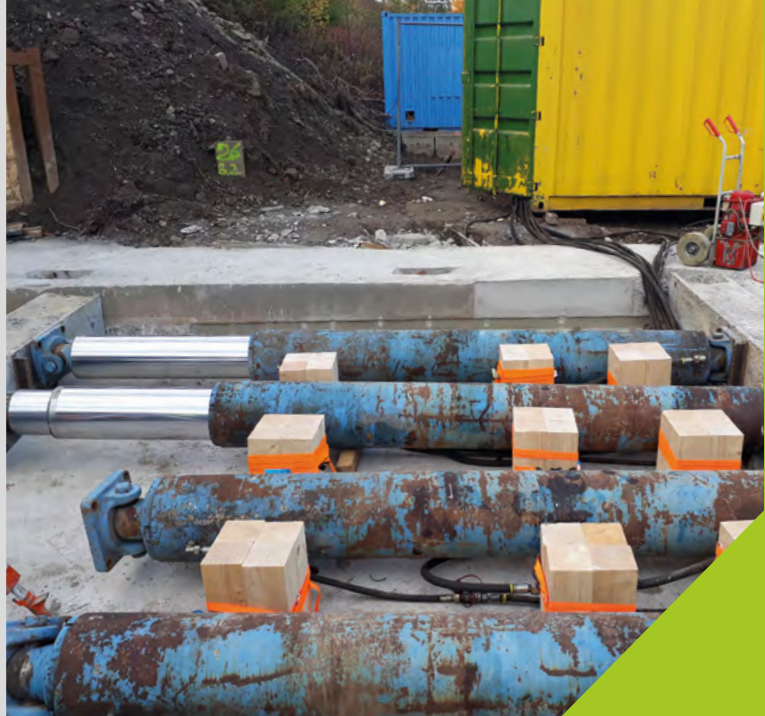
Die Durchpressung der Fertigteile erfolgte durch die VTW Vortriebstechnik Weiss GmbH aus Hünxe mittels einer Pressanlage, die sich gegen das Widerlager auf der einen und auf den Boden des Querschnitts auf der anderen Seite abstützte. (Bild: Ingenieurbüro I-KIS)
