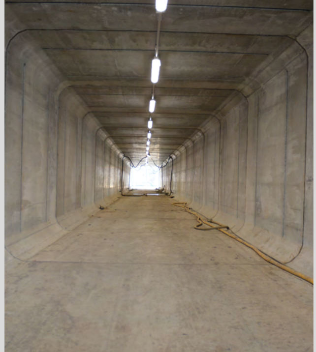
Der Medientunnel setzt sich aus 23 einzelnen rechteckigen Betonfertigteilstegsegmenten aus dem Betonwerk Kleihues aus Emsbüren mit Abmessungen von 4,20 m (B) x 3,50 m (H), einer Wandstärke von 35 cm und Segmentlängen von 2,50 m zusammen. (Bild: Kleihues Betonbauteile GmbH & Co. KG)
