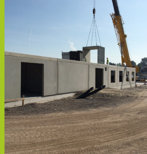
Die Montage der 149 Fertigteile für den Wertstoffhof erfolgte in nur 10 Tagen. (Bild: Modulo Wertstoffhöfe GmbH)
