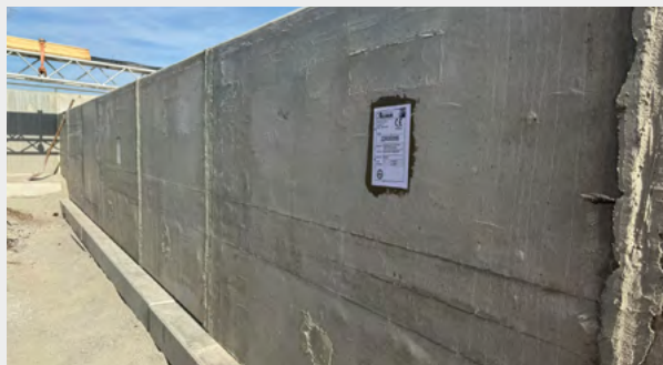
Die Verspannung der Fertigteile erfolgte mit Hilfe eines Stabspannsystems im Verbund. (Bild: KÖNIGBAU GmbH)
