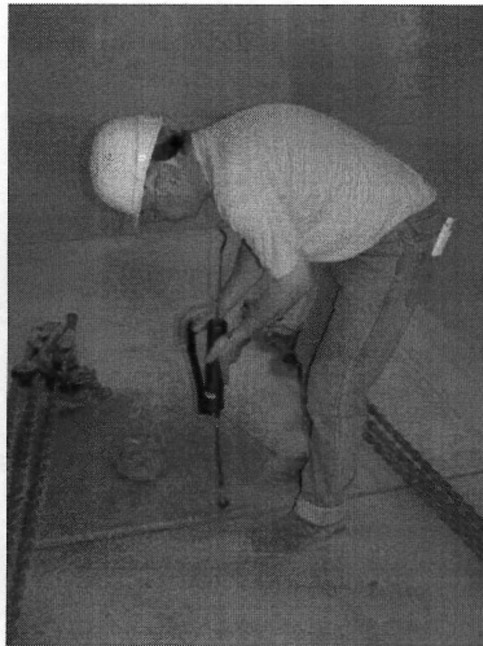
Bild 2: Füllung des Ringraumes der Dichtung
